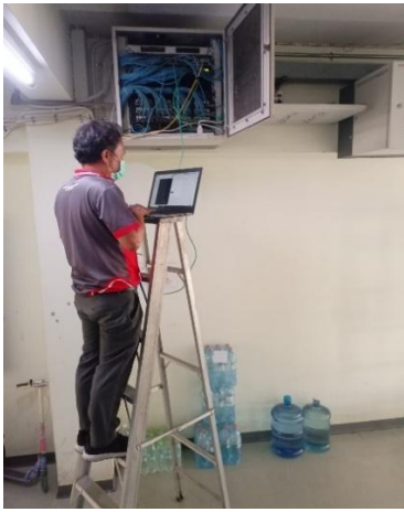
ภาพที่ 42 การบำรุงรักษาอุปกรณ์เครือข่ายคอมพิวเตอร์ประจำอาคาร
